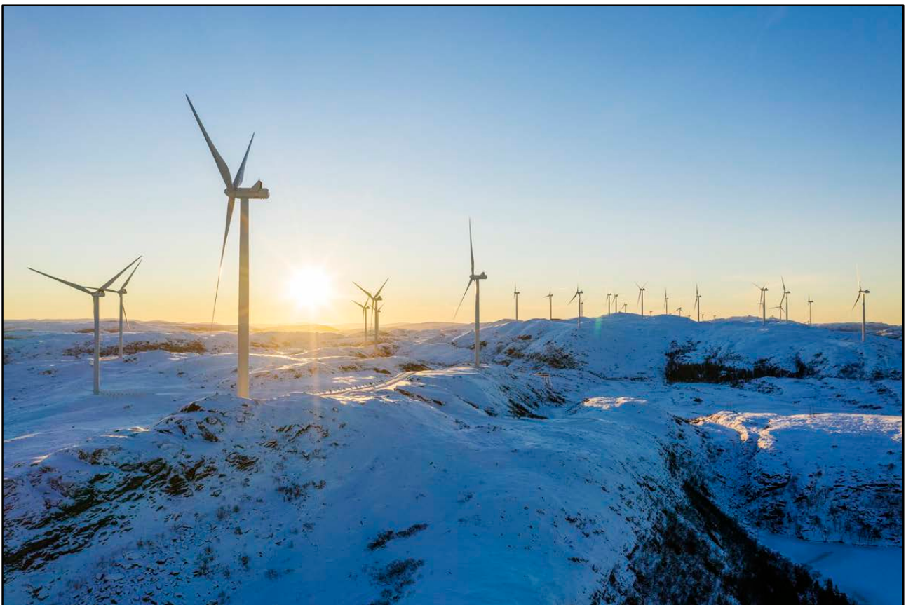
Turbinene i Roan vest er synlige over store avstander. Foto: Ole Martin Wold
