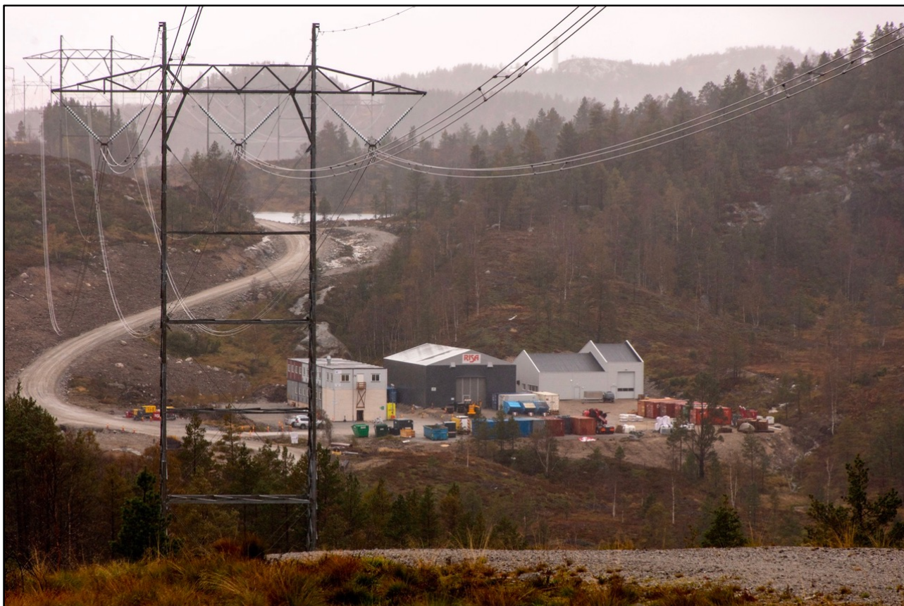
Adkomstveier til kraftverkene og installasjoner utenfor planområdet blir ikke med i arealberegningene. Tonstad vindkraftverk 30. september 2019. Foto: Kaare Finbak
