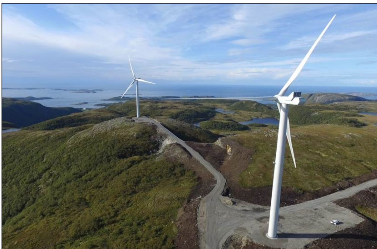
Turbinene i Roan er synlige i miles omkrets. Foto: Fosen Vind.
