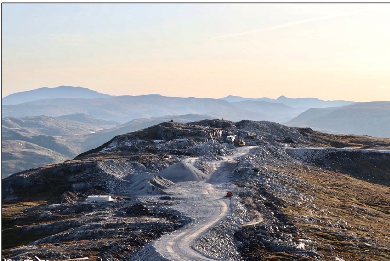
Geitfjellet under bygging. De direkte inngrepene er ikke reversible. Terrenget langt utenfor veibane, skulder og fyllinger blir berørt av bl.a. sprengstein, drenering av myr mm. "Direkte inngrep" omfatter kun selve veibanen med skulder - ikke fyllinger og fysiske inngrep som blir dekket med torv. Foto: Jacob B. Kryvi
