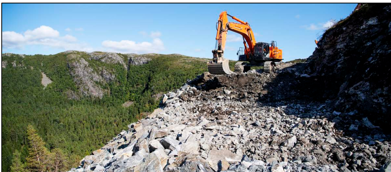
Anleggsvei i Kvenndalsfjellet vindpark. Foto: Ole Martin Wold
