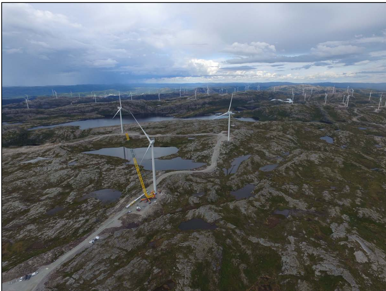
Storheia vindkraftanlegg har et planareal på 37 km 2 med en installert effekt på 288 MW. Anlegget forventes å produsere 979 GWh (0,979 TWh) pr. år. Anlegget produserer 26,5 GWh/km som er gjennomsnittlig produksjon pr. km 2 planareal for alle 26 anlegg i Trøndelag (0,26,293 GWh/km 2 ). Foto: Fosen Vind.
