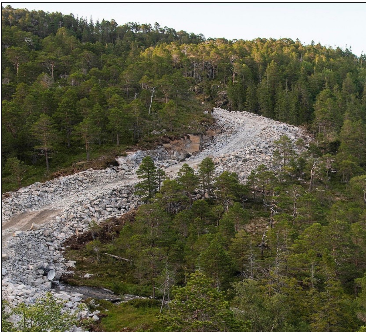
Direkte inngrep er vesentlig bredere enn selve veibanen på 5-6 m bredde. Adkomstveien til Sørmarkfjellet viser tydelig omfanget av det fysiske inngrepet før steinfyllingene tildekkes med myrtorv og jord. Fyllingene blir ikke medregnet som "direkte inngrep" når de tildekkes med torv. Foto: Kjartan Trana
