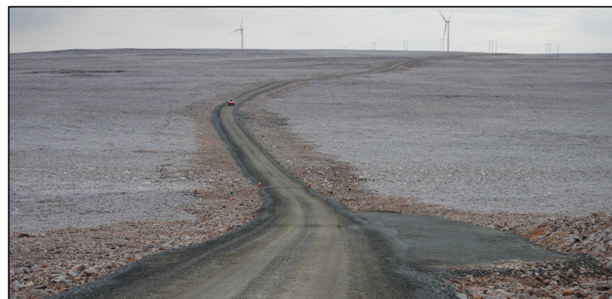
Figur 3. Adkomstvegen til Raggovidda vindkraftverk. Forholdene på Raggovidda og Davvi er veldig like, så bildet gir et godt inntrykk av hvordan anleggsvegene på Davvi vil fremstå. Foto: Multiconsult Norge AS.
