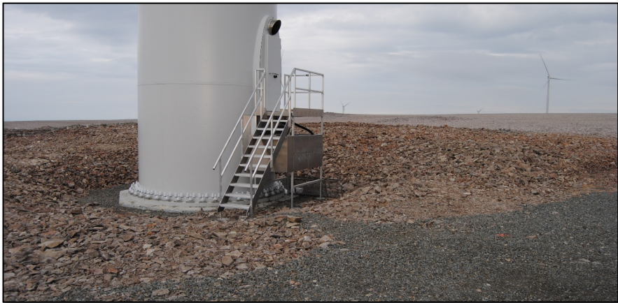
Figur 4. Fundament og tårn etter tilbakefylling av masse (Raggovidda vindkraftverk).
