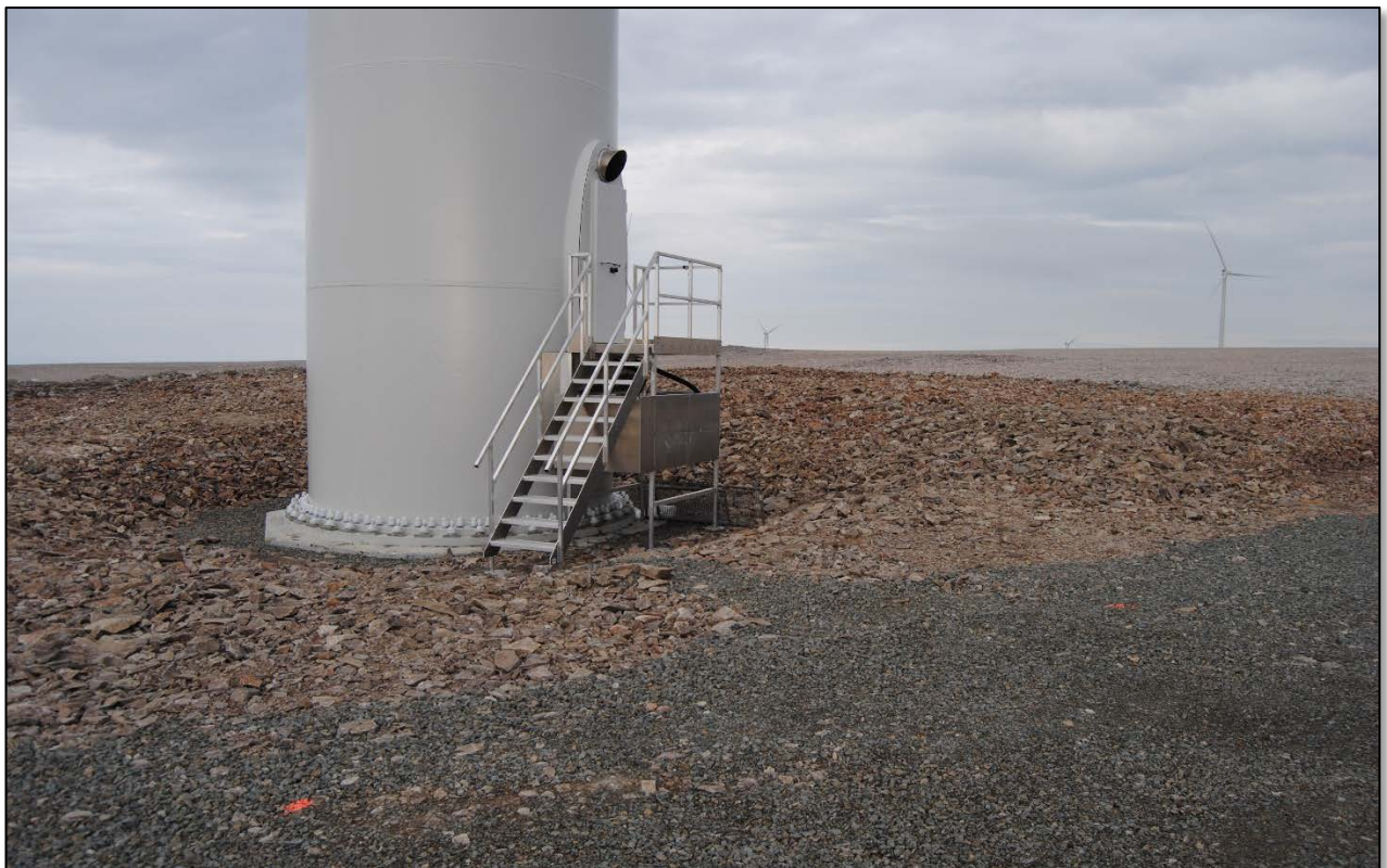
Figur 6-2. Støping av turbinfundament i Raggovidda vindkraftverk (over) og fundament/tårn etter tilbakefylling av masse (under). Mest sannsynlig vil det bli valgt samme type fundamentering på Davvi. Foto: Multiconsult Norge AS.
