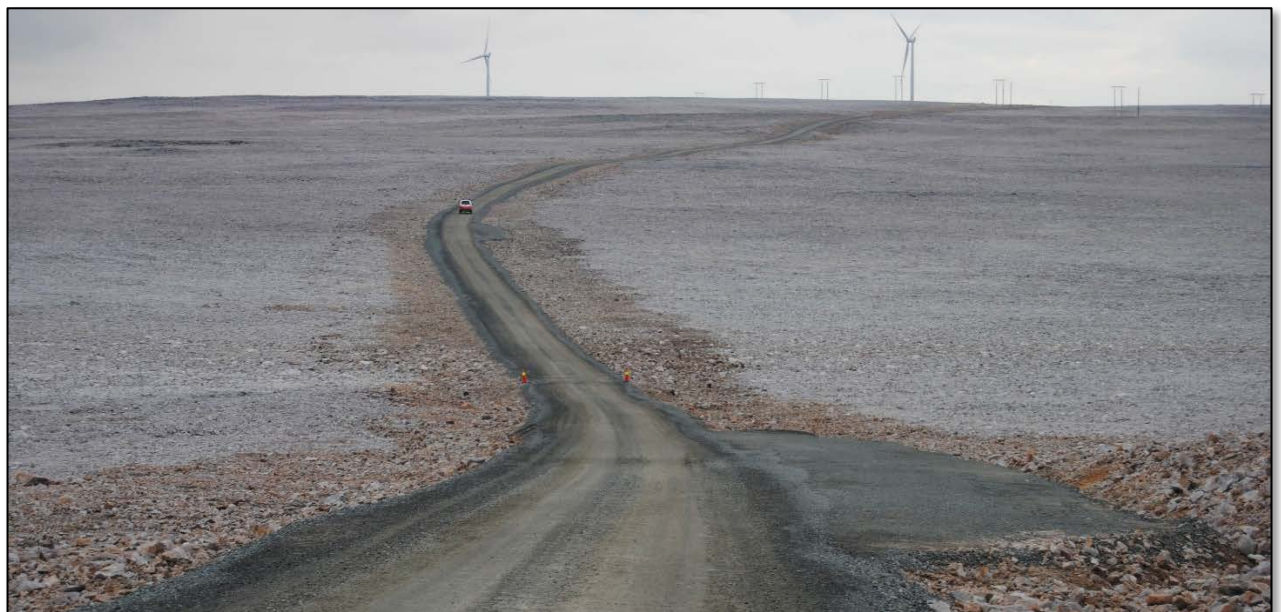
Figur 6-4. Adkomstvegen til Raggovidda vindkraftverk. Forholdene på Raggovidda og Davvi er veldig like, så bildet gir et godt inntrykk av hvordan adkomst-/internvegene på Davvi vil fremstå. Foto: Multiconsult Norge AS.
