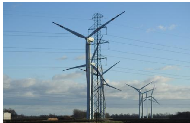
Dette er ikke vindmøller, men vindturbiner. Vindkraftverket Bystra i Polen. Her er turbinene satt opp i et flatt jordbruksområde og inngrepa blir da mye mindre enn i Norge. Disse turbinene som er satt opp i 2012 er på 2 MW hver og total høyde på 123 m. Det er langt mindre enn det som nå settes opp i Norge. Moderne vindturbiner minner lite om de tradisjonelle vindmøllene. (Foto: Svein Lund)
