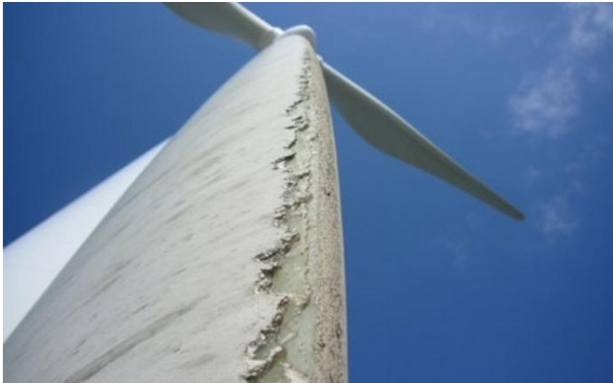
Slitasje på turbinvinge
