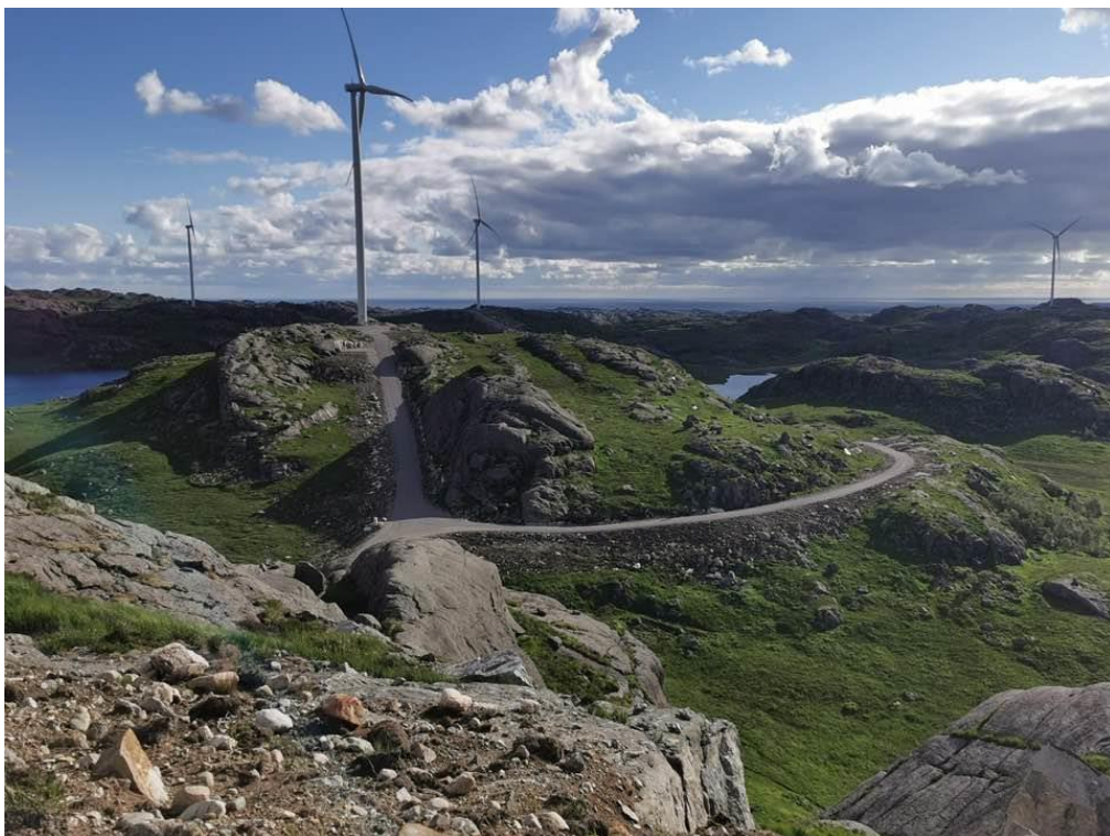
Bjerkreim vindkraftanlegg (70 turbiner)
